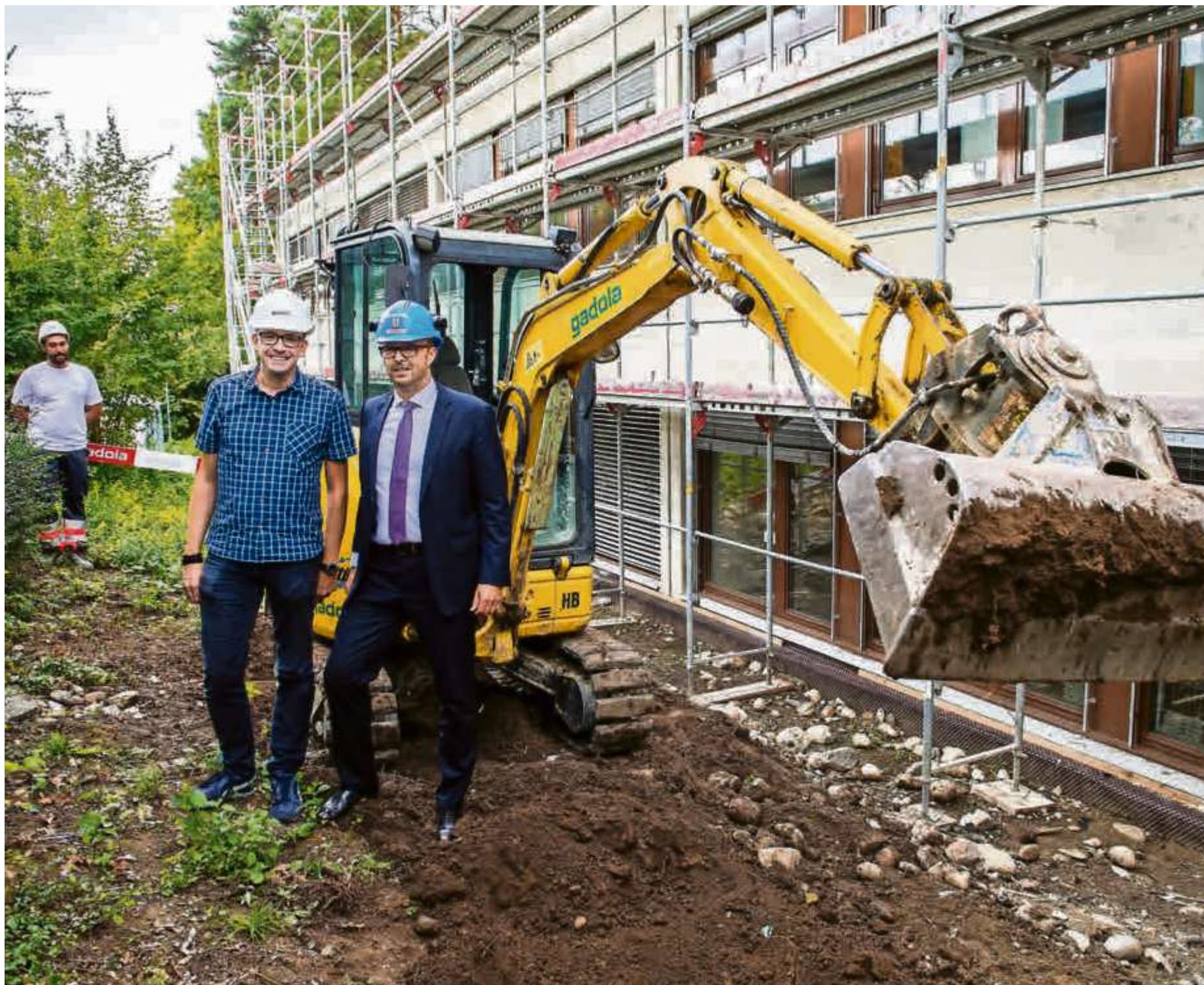
Gestern luden Oberstufen-Schulleiter Andi Rätz und Gemeindepräsident Marco Hirzel zum Spatenstich ein.
