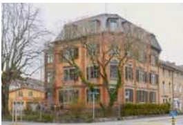
Darf abgerissen werden: Das Wohnhaus mit rostroter Klinkerfassade an der Salstrasse in Winterthur ZH. ZVG
