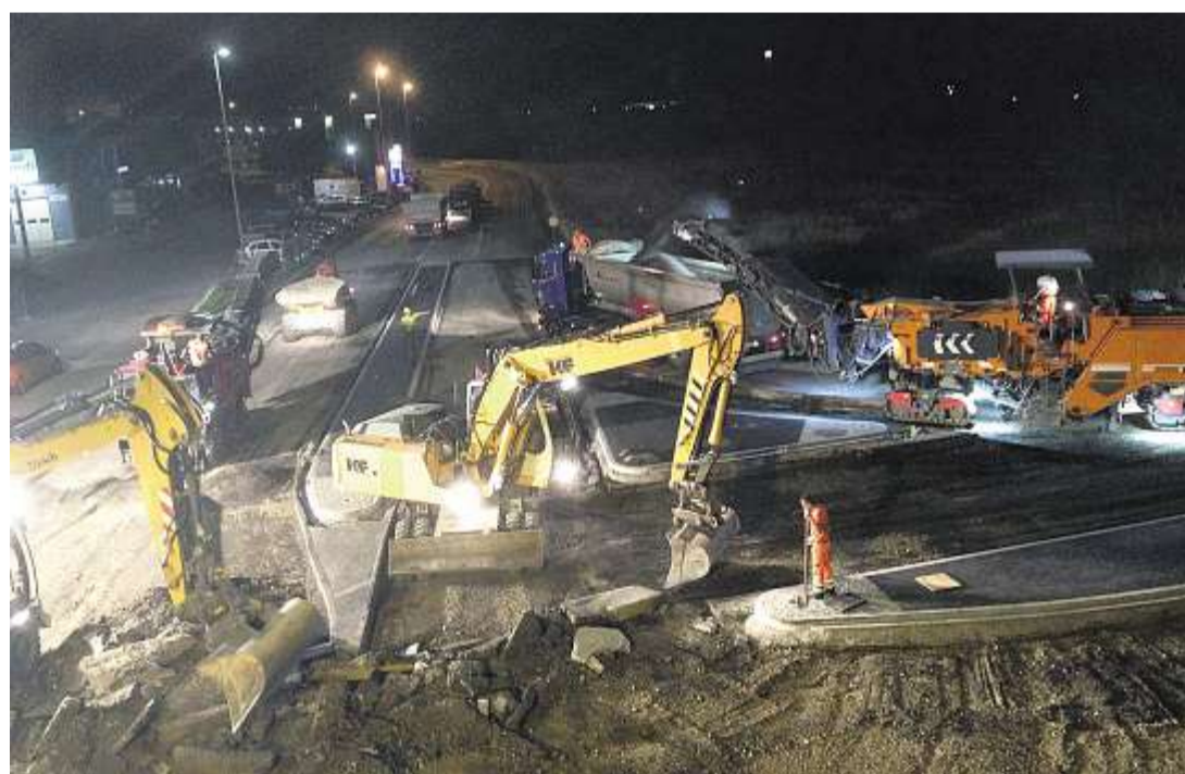
Kaum ist die Sonne untergegangen, beginnen die Grossfräsen, den alten Belag zu beseitigen. Hierfür wird die ganze Freitagnacht konzentriert gearbeitet.
